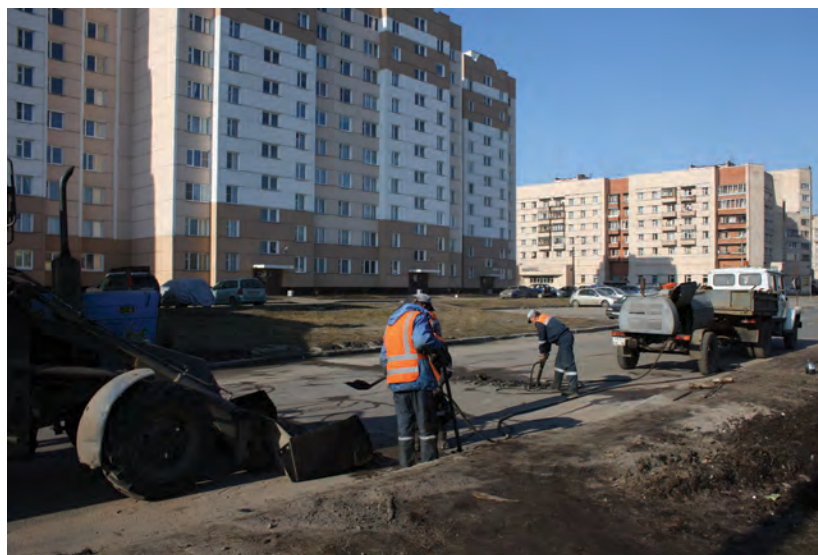
Ремонт дороги на Университетском проспекте
