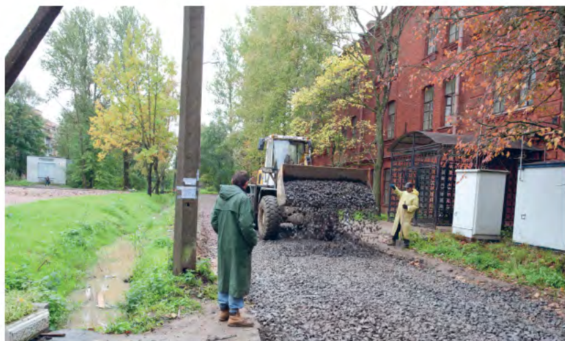
Ремонт дороги на улице Юты Бондаровской
